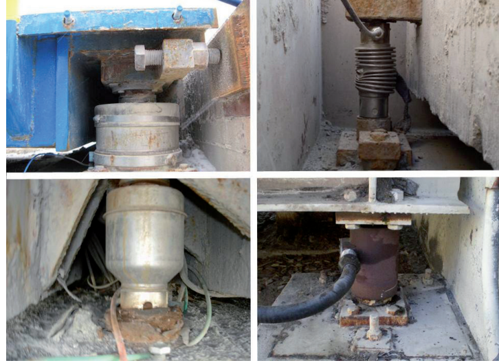
Veraltete Wägezellensysteme können zu wiederkehrenden Problemen bei Fahrzeugwaagen führen.
