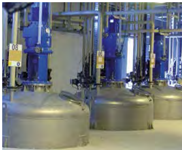
Рис. 2. Резервуарные весы, установленные в отверстии перекрытия.
