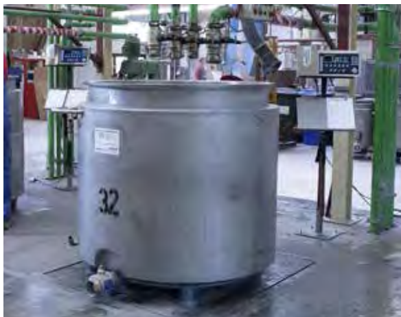
Емкость с неприсоединенными трубопроводами.
