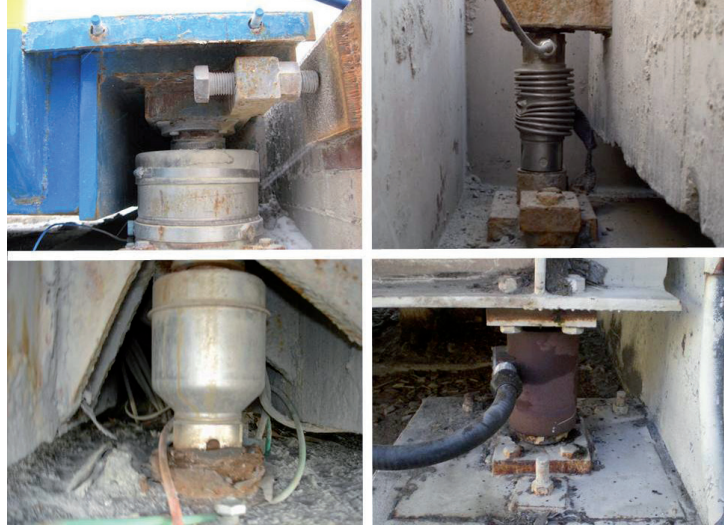
Zastaralé systémy snímačů mohou způsobovat časté potíže se silniční vahou.
